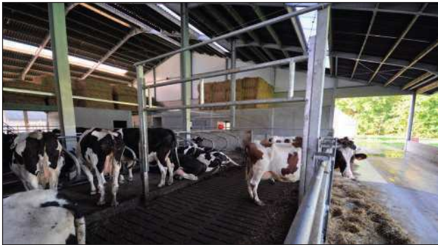
eenrichtingspoort met 1 of 2 doorgangen séparation anti retour avec 1 ou 2 passage
