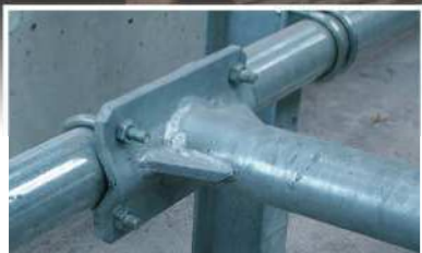
versterkte kopplaat tôle de fixation renforcé
