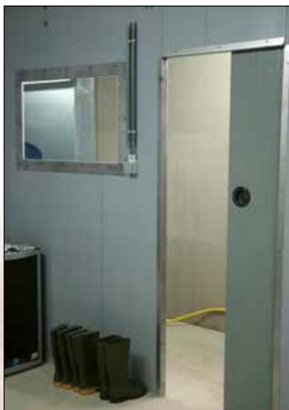
sanitair lokaal pour locaux sanitaires
